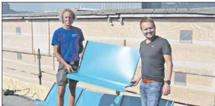
Andreas Köstner mit Bauleiter David Thumfart am Dach der Linzer Tabakfabrik.
