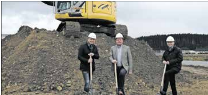
Ing. Klaus Lohninger, Roland Lohninger und Bgm. DI Gunter Schimpl beim symbolischen Spatenstich für das größte Projekt in der Firmengeschichte.
