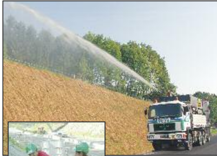
oben: Spezial-Aufspritzbegrünung mittels Großtankgerät
