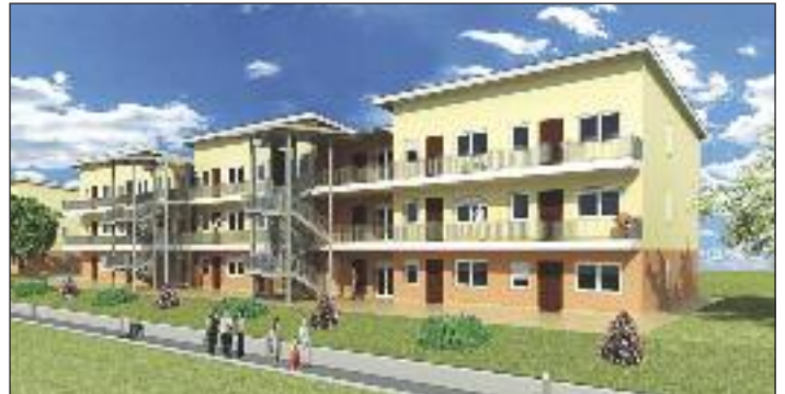
20 Wohnhäuser mit einem Auftragswert von € 42,4 Mio errichtet WOLF Haus in den Abruzzern.
