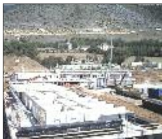
Aktuelles Baustellenfoto vom 15. Juli.
