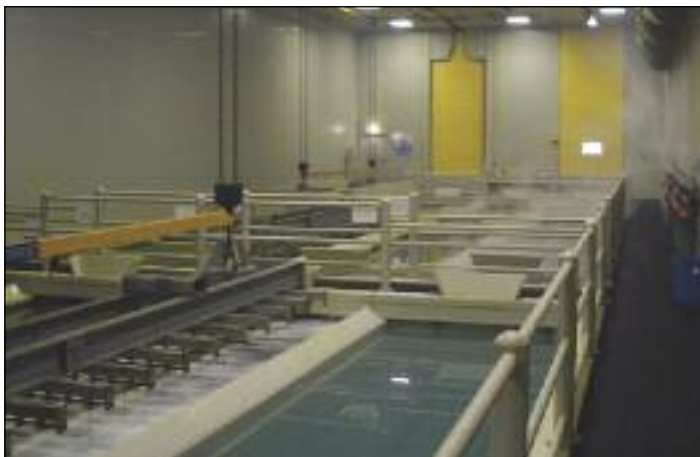
Vorbehandlungshalle in einer Verzinkerei
