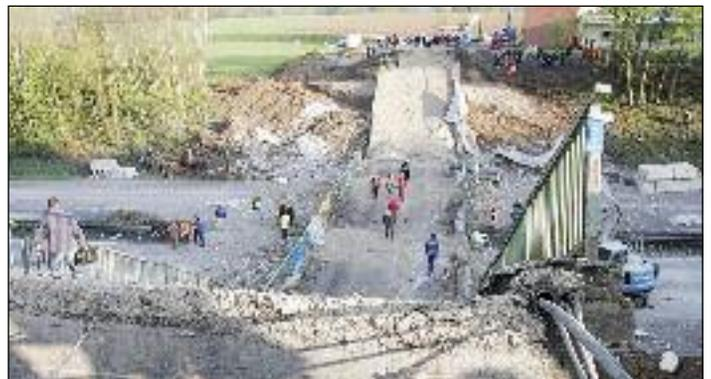
Normalerweise werden Autobahnbrücken abgetragen. Aber in diesem Fall war das nicht möglich. „Die 60 Meter lange Brücke ist mit zwölf Metern außergewöhnlich hoch und hat keinen Mittelpfeiler. Bei Abbrucharbeiten wäre die Gefahr für die Arbeiter groß, von einstürzenden Brückenteilen getroffen zu werden“, sagte Asfinag-Experte Alfred Dornetshuber.
