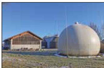
Biogas Kläranlage erzeugt 230 MWh pro Jahr
