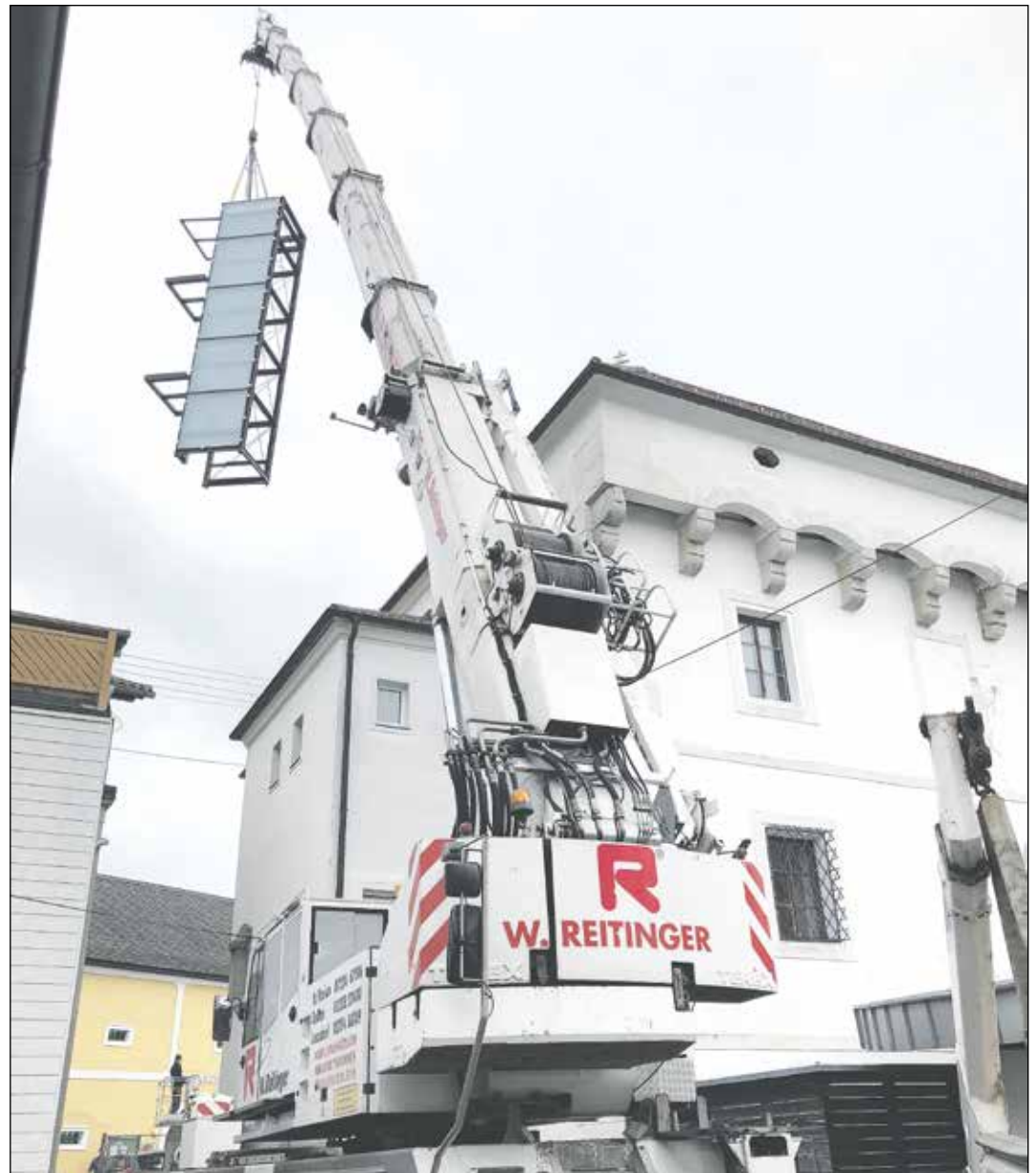
Das Schloss Hochhaus wird barrierefrei: spektakuläre Montage im Vorchdorfer Zentrum
