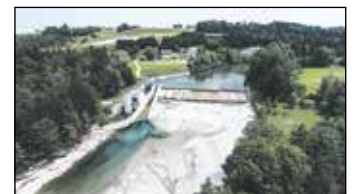
Die lokale Kronawett Kraftwerks GmbH liefert Ökostrom aus der Alm für die geplante Stromtankstelle.
