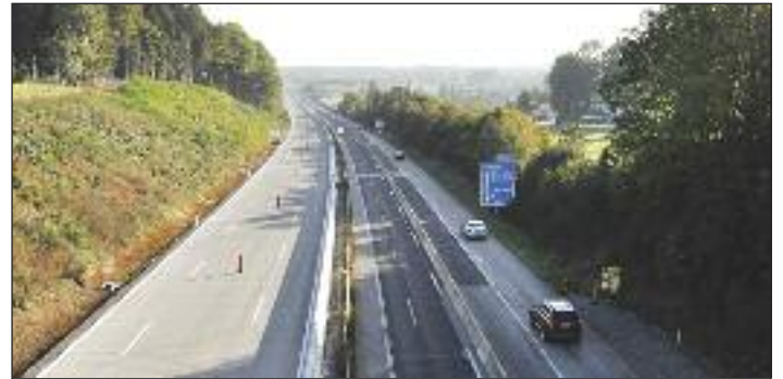
Blick von der „Weinbergmair-Brücke“
